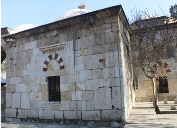
Fotoğraf:22 -Yörgüç Paşa Cami, Güney Kuzey Cephe, (İ.Gültekin, 2017)
