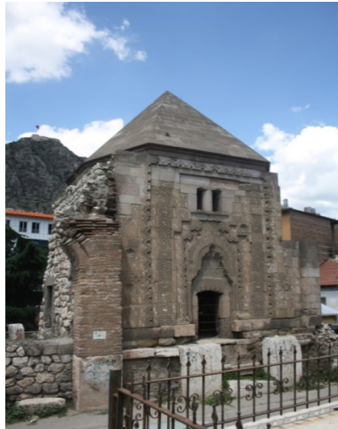
Fotoğraf:1 -Halifet Gazi Türbesi, Güney Cephe (İ.Gültekin, 2017)
