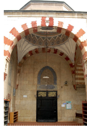
Fotoğraf:23 -Yörgüç Paşa Cami, Kuzey Cephe, Giriş Eyvanı (İ.Gültekin, 2017)
